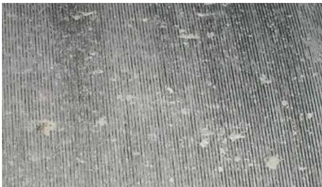
Rillenwalzenoberfläche vor der Installation des RS AirBlade.
