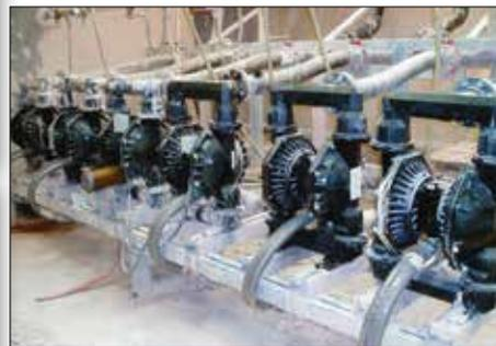
3" (76,2 mm) Membranpumpe eingesetzt zur Förderung von Schlacker in einer Keramikproduktion.
