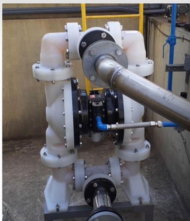
La pompe non métallique ARO EXP 3" est bien adaptée au transfert efficace de produits chimiques.
