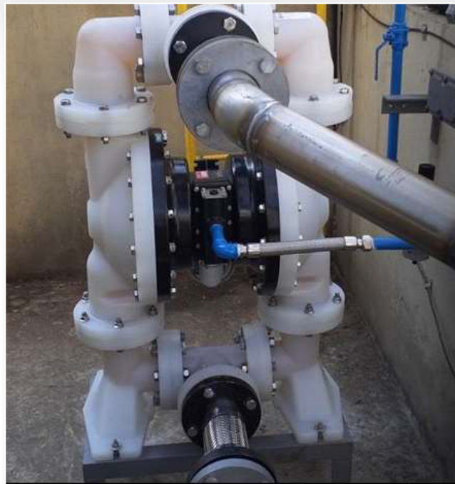
ARO EXP 3インチ非金属ポンプは、化学薬品の効率的な移送に適しています。
