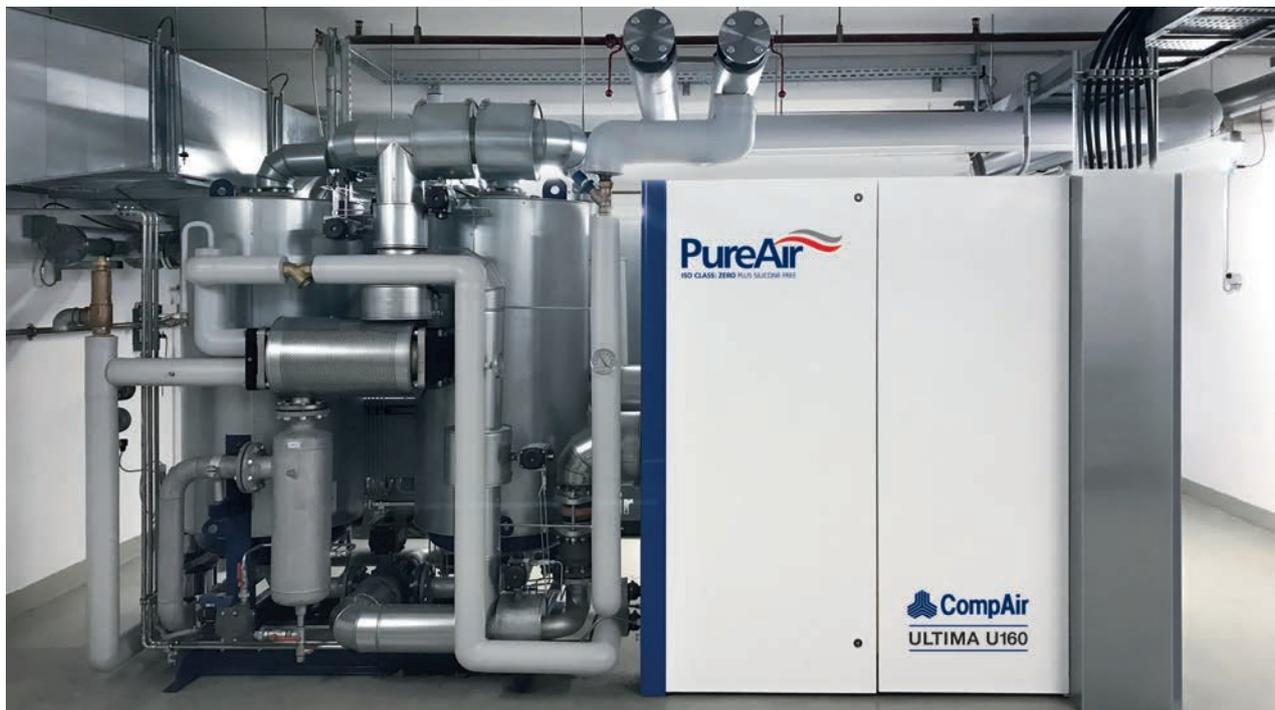
**Zur Trocknung der feuchten Druckluft wird ein HOC (Heat Of Compression)-Trockenmittel-Trockner (links) eingesetzt. Dieser nutzt fast die gesamte Abwärme des Kompressors zur Regeneration des Trockenmittels.**
