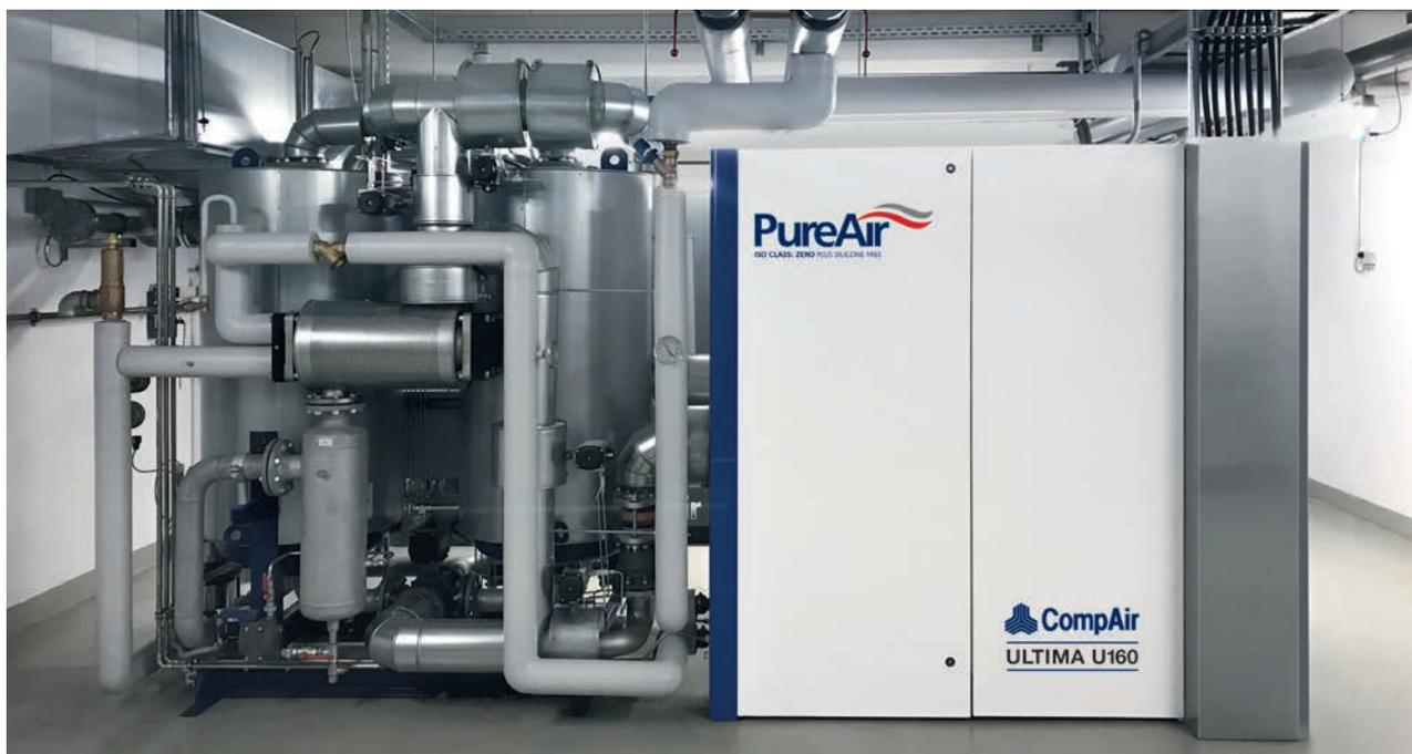
**Pour sécher l'air comprimé humide, on utilise un sécheur par dessiccation HOC (Heat Of Compression) (à gauche). Il utilise presque toute la chaleur résiduelle du compresseur pour régénérer le dessiccant.**
