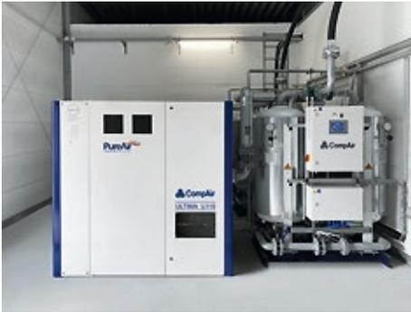
Die U110RS-10W Kompressoren und UHOC 1700-B Adsorptionstrockner arbeiten inzwischen mehr als 5.000 Betriebsstunden störungsfrei.
