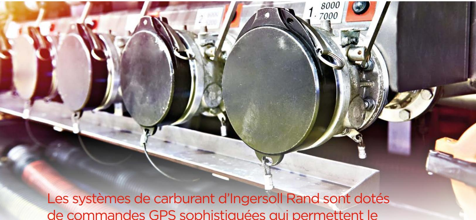
**Les systèmes de carburant d'Ingersoll Rand sont dotés de commandes GPS sophistiquées qui permettent le déchargement du carburant uniquement dans des limites géographiques programmées.**
