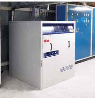
Secteur industriel : un célèbre producteur de pâtes a fait confiance à Robox Screw pour le transport pneumatique de farine et de sucre, car il assure des températures de fonctionnement inférieures, il ne présente aucun risque de détérioration du matériau transporté et fournit un rendement énergétique élevé.
