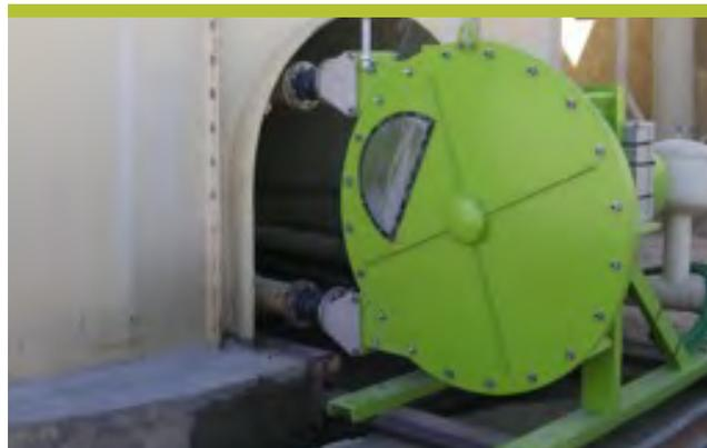
O funcionamento lento da nossa bomba, combinado com a mangueira de borracha natural (NR), permite a vida útil prolongada da mangueira. Nossas mangueiras de NR são perfeitamente projetadas para lidar com líquidos abrasivos.
