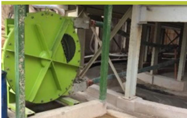
In Sudafrica, Albin Pump® ha fornito 2 gruppi pompa ALH125 tarati a 55 m³/h ciascuno (25 giri/min), che non subiscono un'eccessiva usura abrasiva. La durata del tubo è principalmente correlata alla velocità della pompa. Le nostre pompe ALH125 funzionano continuamente, 24 ore su 24, 7 giorni su 7, e la durata del tubo è superiore alle aspettative del cliente.
