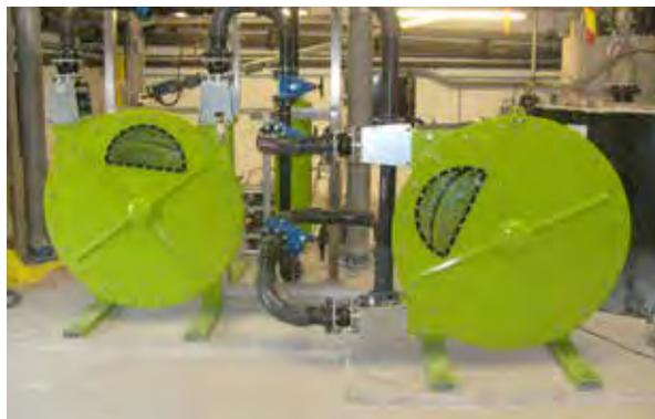
Manuseio de água de cal da ALH100 em uma estação de tratamento de águas residuais
