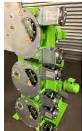
Bombas ALH25 empilhadas, usadas para distribuição de leite de cal em uma estação de tratamento de água municipal
