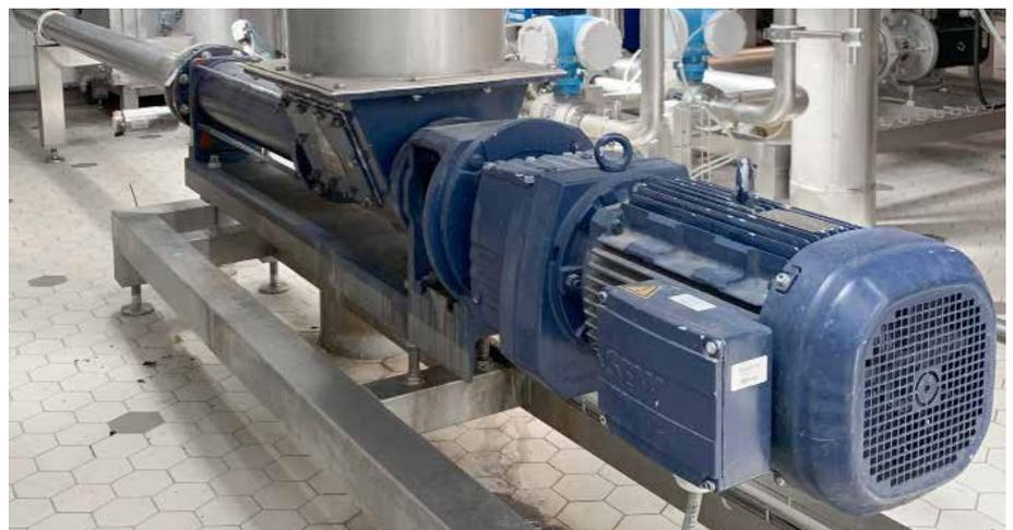
Der Trichter der BTQ 35-12 lässt sich durch beidseitige Inspektionsklappen gut reinigen.
