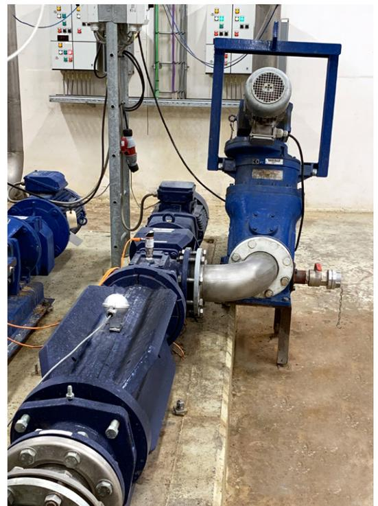
BN 52-12S SCT mit Pump Monitor-Sensoren in der Aufbereitungsanlage.
